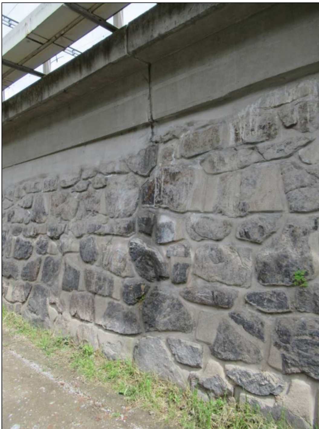
Obr. č. 9 – pohled na opěrnou zeď zprava (průsaky skrze dilatační spáru v římse)
