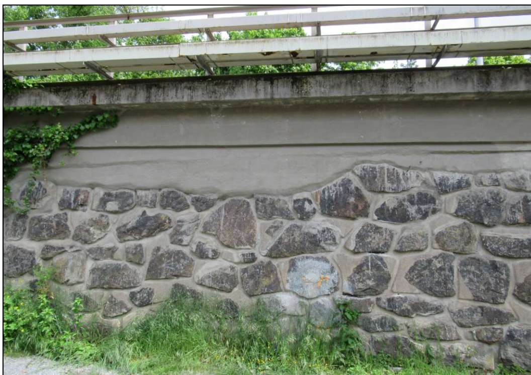
Obr. č. 8 - pohled na opěrnou zeď z příjezdové komunikace (nově zrekonstruovaná vrchní část zdi)
